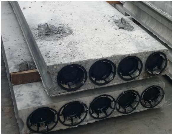
4 pav. Kėlimo kilpos siauroje plokštėje
